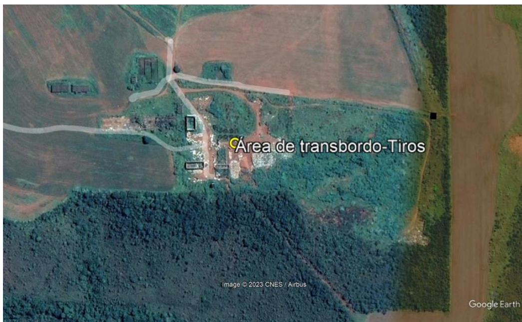
Figura 69 – Estação de transbordo em Tiros (18°59'8.82"S / 45°56'55.69"O)
