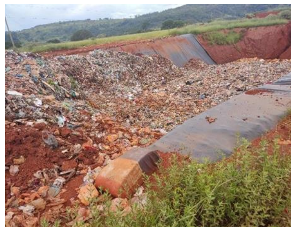
Figura 55 – Vala no local de disposição final
