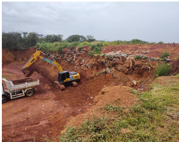
Figura 44 – Abertura de Vala de Rejeitos em Presidente Olegário.
