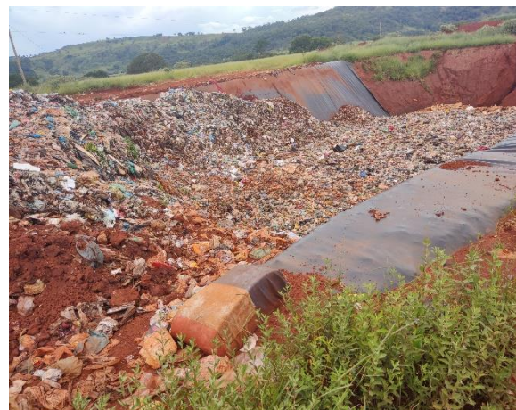
Figura 57 – Vala no local de disposição final
