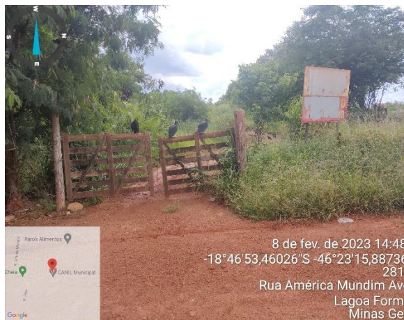
Figura 56 – Entrada do local de disposição final
