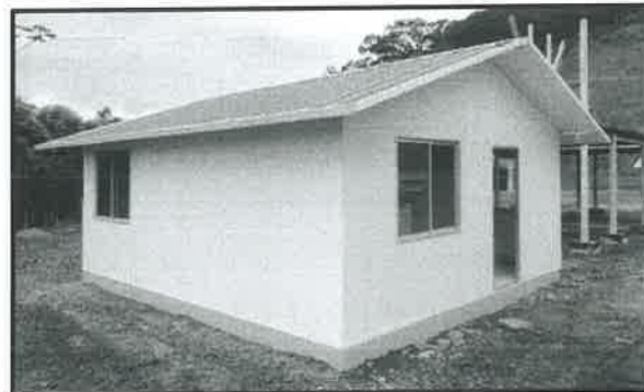
Figura 2- Casa em construção.
