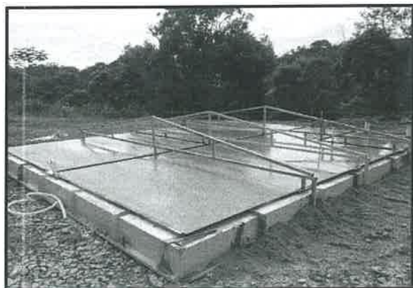
Figura 75 – Radier após concretagem e superfície acabada.
