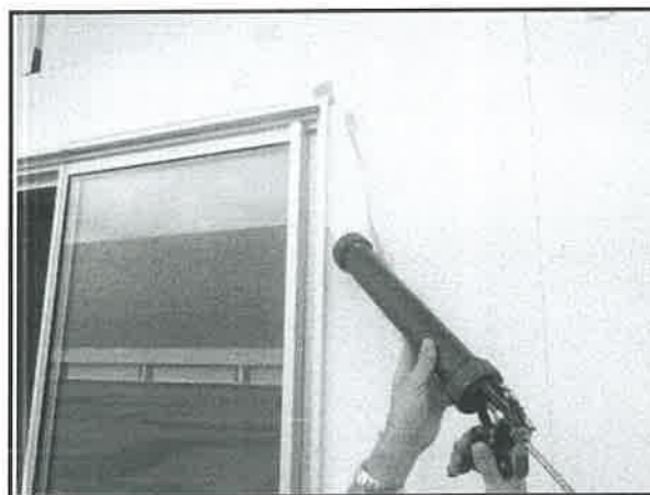
Figura 51 – Vedação com selante das extremidades da janela.
